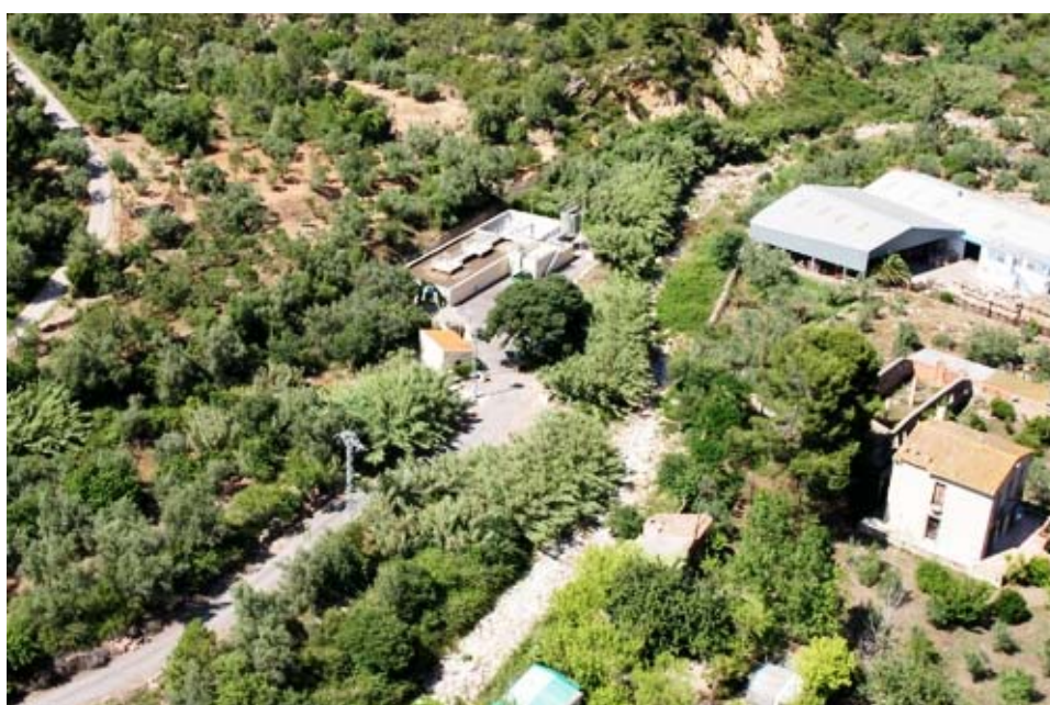
Foto 3. Imagen de la EDAR de Eslida (fotografía perteneciente a EPSAR).
