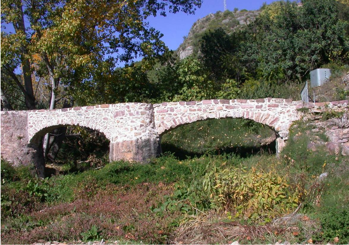
Foto 8. Barranco de Castro a su paso por Eslida
